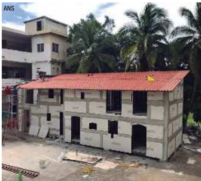
Construcción de la casita de I Becchi en Panamá, en lo que será el “Valdocco de América”.
