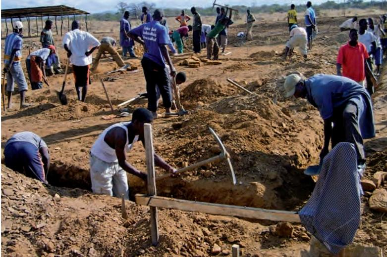
fabricaron los bloques de hormigón con los que construiríamos la casa, mientras que los demás se encargaron del replanteo de la obra, o participaron en las extenuantes labores de excavación de las cimentaciones.
