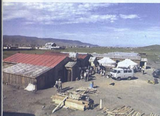
Centro salesiano para niños de la calle, en construcción
