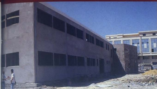
Estado de las obras
