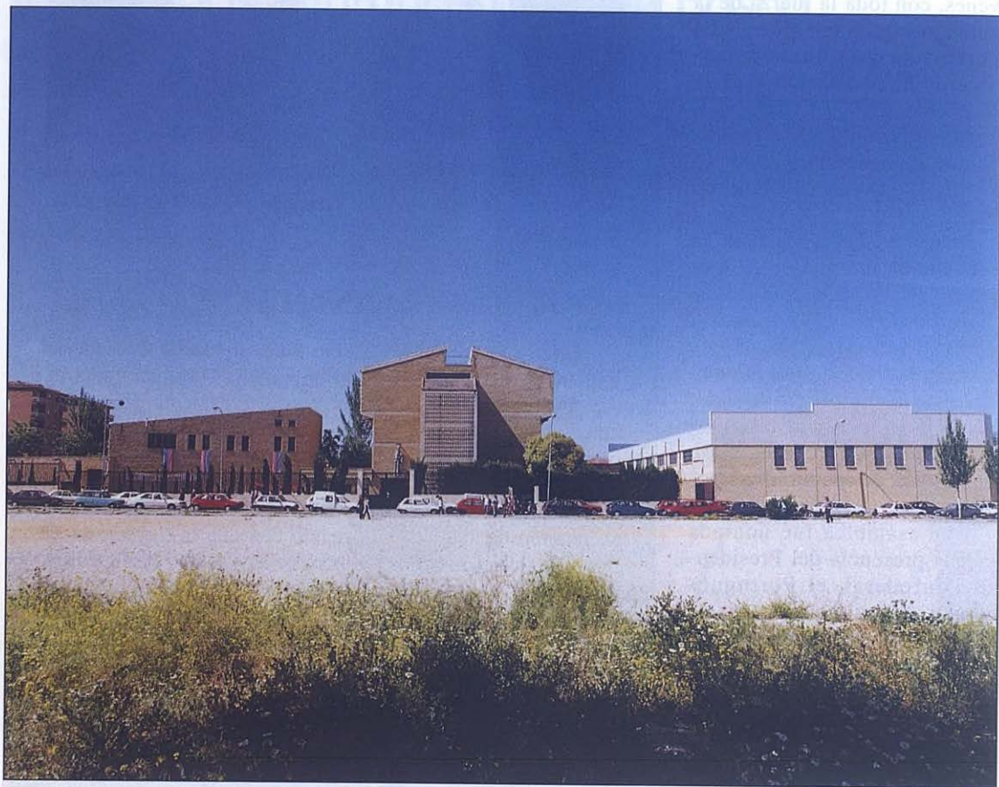
■ Vista general del colegio con el polideportivo a la derecha.
