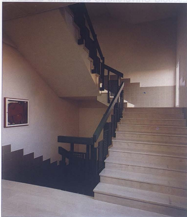
EPS, detalle de escalera interior
