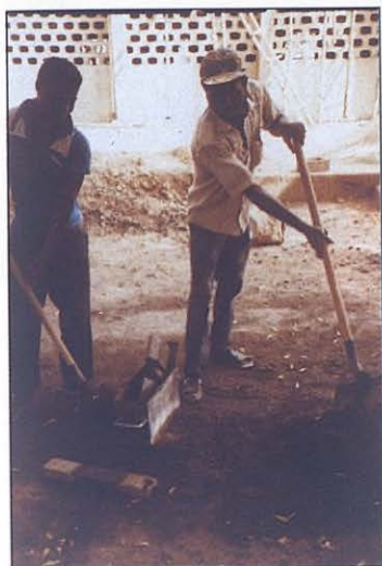
Benin: proceso de elaboración de bloques de hormigón. Los utilizan en la obra que dirigió Carlos César.
