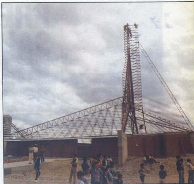
Trelew (Argentina): Santuario Nuestra Señora del Carmen, en construcción.
