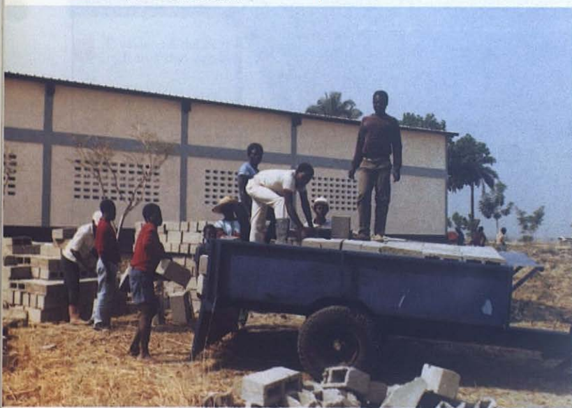
La obra salesiana de Kará, en plena construcción.
