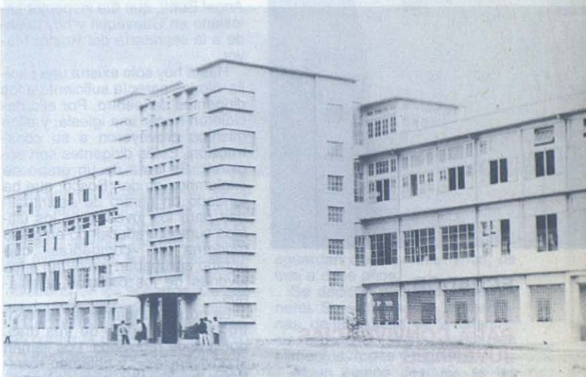
SCHILLONG (India): Seminario Menor, obra del salesiano coadjutor, arquitecto Santi Montano.
