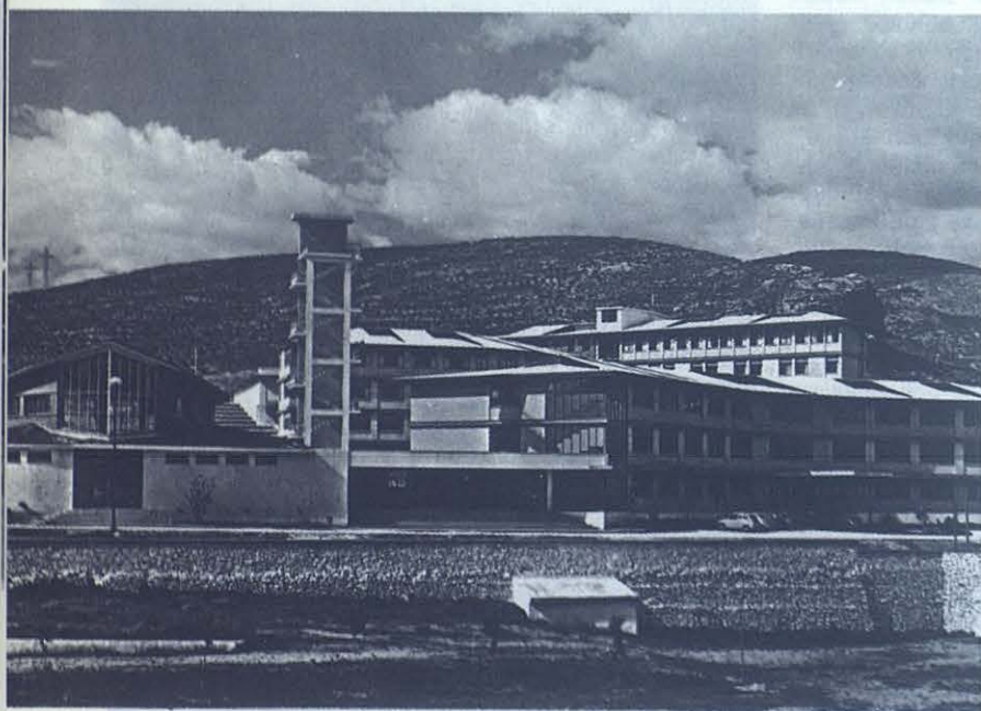
CUENCA: Fachada exterior del Colegio Salesiano.
