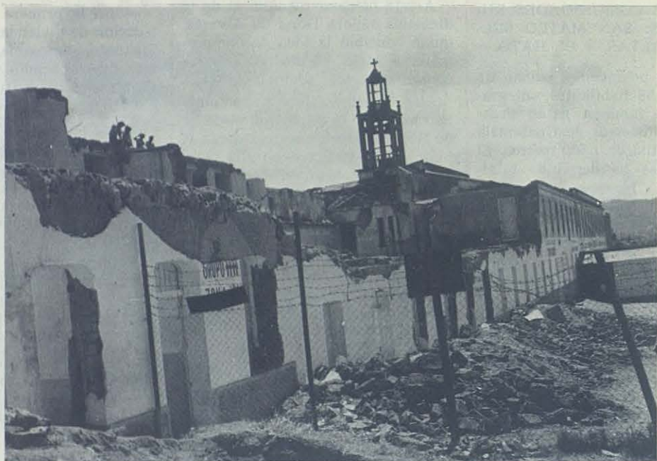
Así quedó el edificio del «Centro Social», del Colegio Don Bosco.
