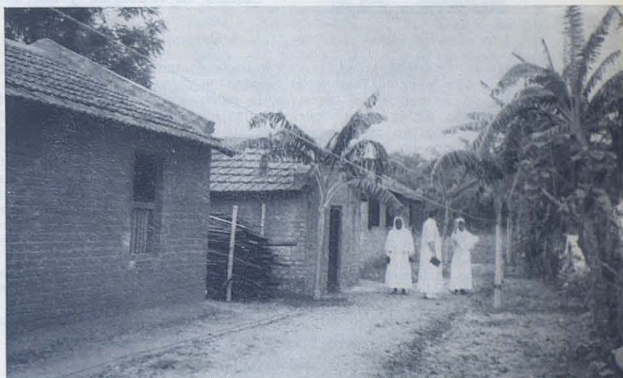
Junto a la selva, las nuevas casitas. El padre Jiménez inspecciona el tendido de la línea.
