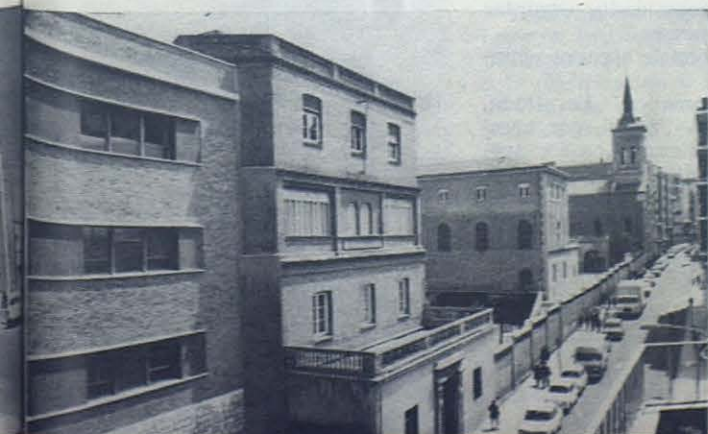
Madrid: Casa Inspectorial de Villaamil.
