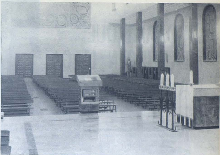
En la foto puede apreciarse la profundidad del nuevo templo y el juego de vidrieras laterales.
