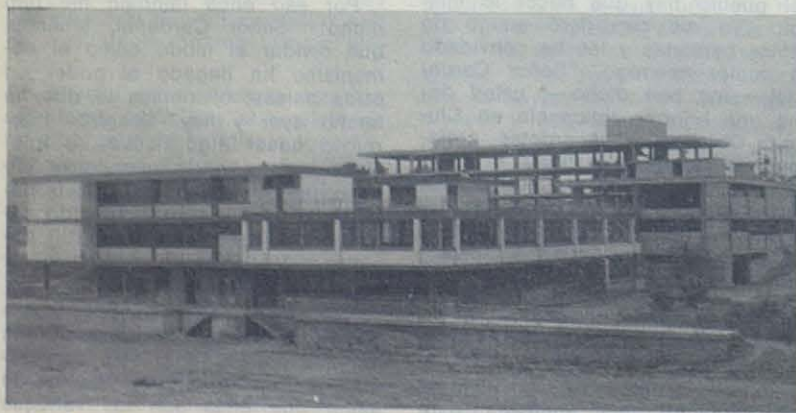
En primer término, los talleres; en segundo plano, la nueva residencia.
