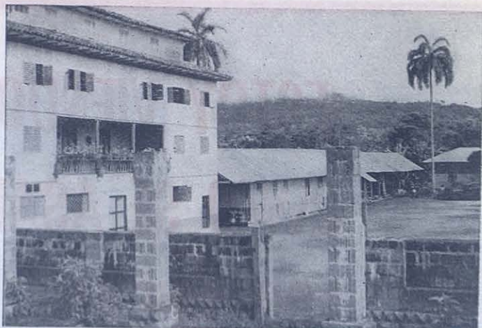
Vista parcial del edificio que ardió.
