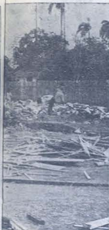
retirar los escombros.
