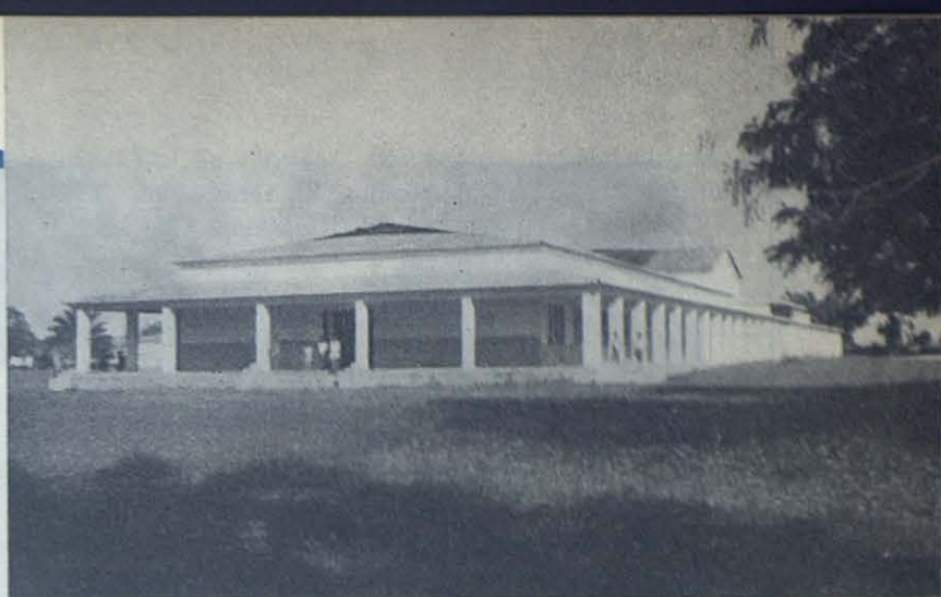
FUILORO (Timor).— La casa de Don Bosco, construida en su buena parte con aportaciones de españoles, amigos de las misiones salesianas. 100 metros de longitud y 16 de anchura, paraíso jamás soñado por los padres, que ahora ben-
