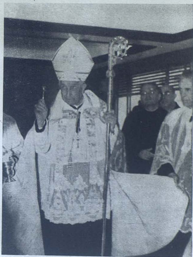
MADRID.—Momento en que el señor Arzobispo de Valencia procede a la bendición del edificio. Este se halla situado en la calle de Alcalá, cerca de la plaza de Roma, y con buenas comunicaciones con cualquier punto de la capital.
