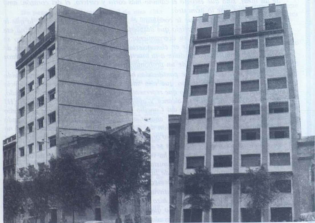
MADRID.—El nuevo edificio de la Casa Salesiana San Juan Bosco para Central Catequística y Casa del Boletín Salesiano (de perfil y de frente), que fue solemnemente bendecido e inaugurado el 28 de mayo.
