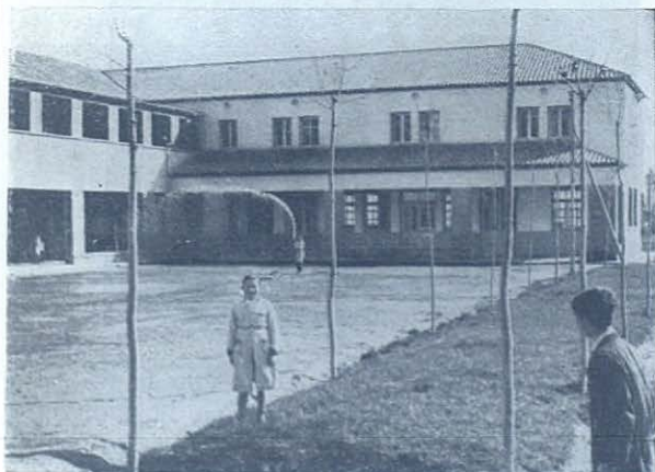
Un patio interior del nuevo Seminario para aspirantes a Coadjutores.
