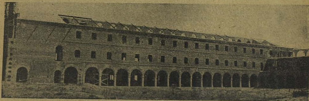
AREVALO (Avila): Otra vista de las obras del Seminario que, gracias a la caridad de los Cooperadores, han prosperado grandemente.
