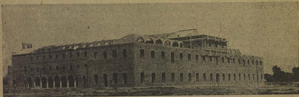
AREVALO (Avila): Aspecto que ofrecían en mayo las obras del nuevo Seminario Salesiano en construcción.
