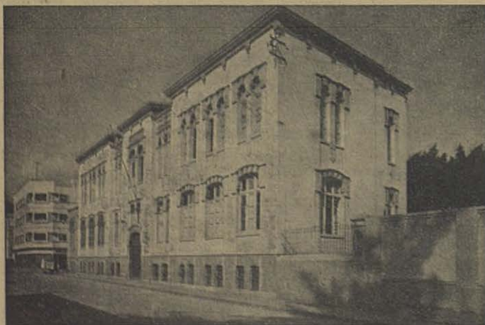
SANTA CRUZ DE TENERIFE. Edificio de las Escuelas Profesionales Salesianas, de cuya fundación dimos noticia en el número de junio. ¡Cuántas escuelas como éstas se podrían fundar si se multiplicaran poderosamente los Coadjutores Salesianos en nuestra Patria!
