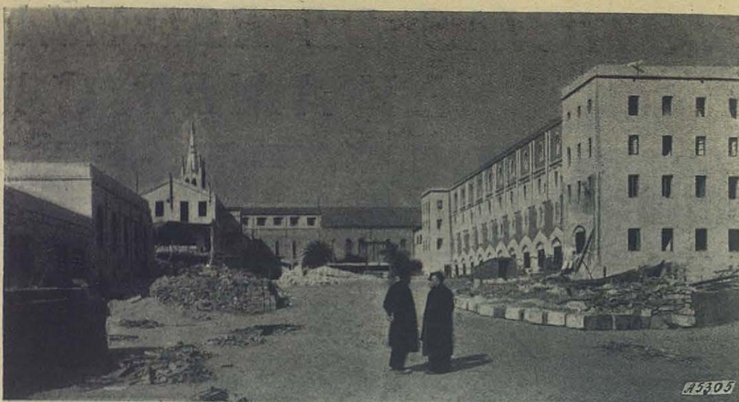
Aspecto desolador de nuestras Escuelas de Sarriá al ser abandonadas por los rojos.
