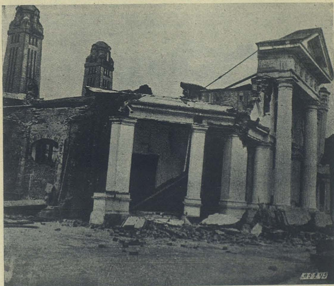
Estado lastimoso de la fachada del cementerio de Concepción.
