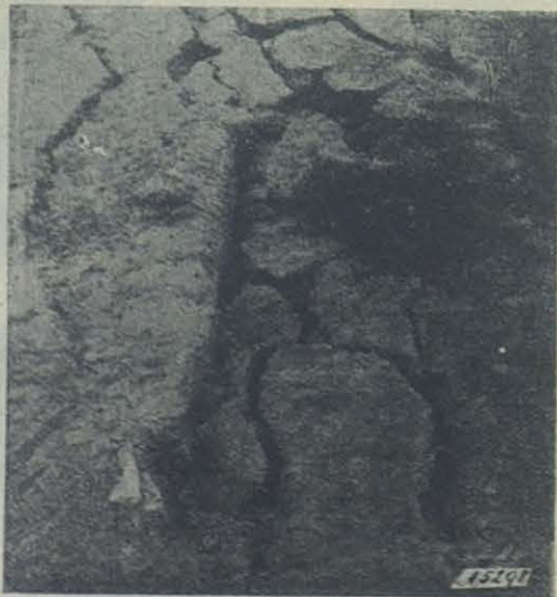
En muchas parte se formaron en la tierra grietas anchisimas.
