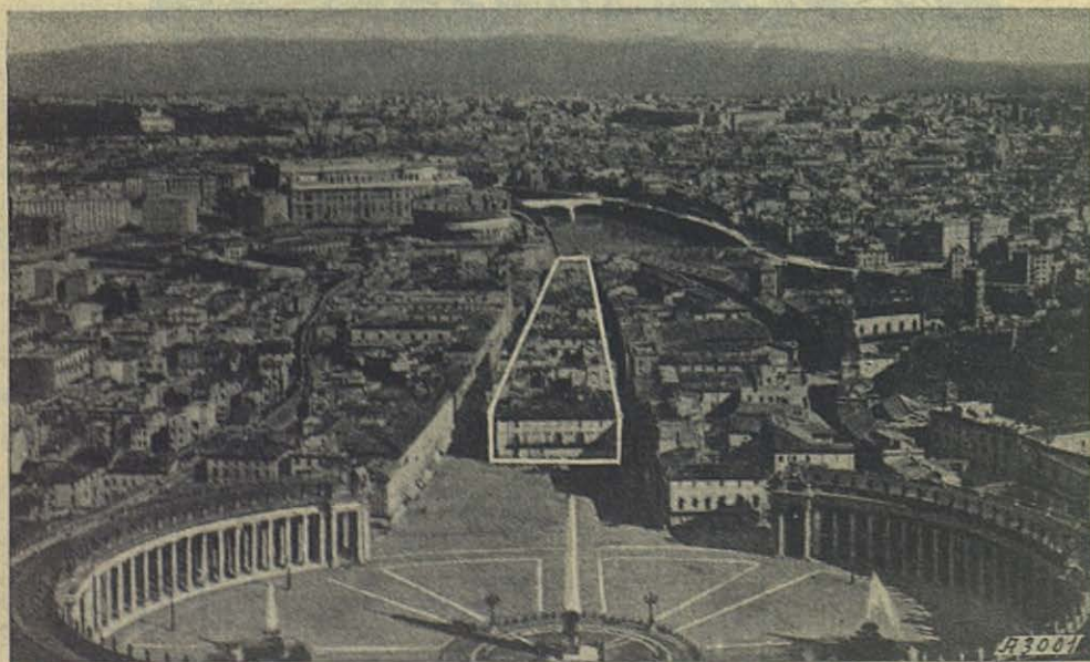
En esta fotografía, se ve, de un modo clarísimo, la famosa spina , cuya demolición inició solemnemente el Duce, el 29 del pasado octubre. Con esta reforma, Roma imperial y papal añadirá un nuevo elemento de belleza a los muchos que ha adquirido en estos últimos años, y la monumental Plaza de San Pedro tendrá un acceso digno de su grandiosidad.
