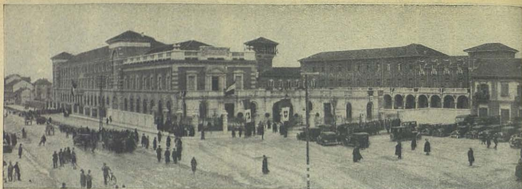
Vista general del Instituto "Conti Rebaudengo".
