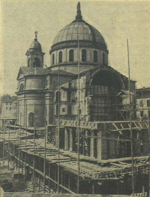
Estado actual de las obras de la Basílica.
