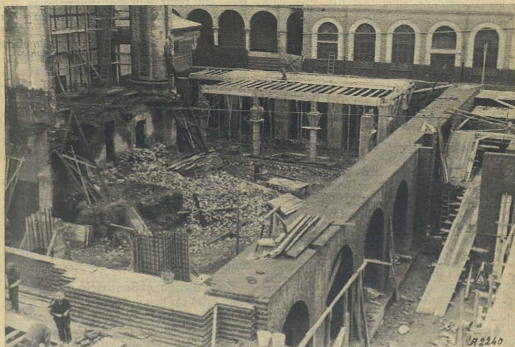
Cómo se hallan actualmente las obras del Santuario.
