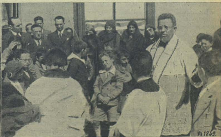
El Párroco, Don Federico Torre, da las gracias después de la inauguración de la calle.
