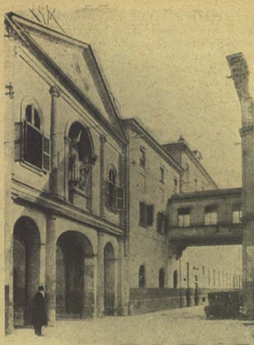
Fachada de la "Piccola Casa".
