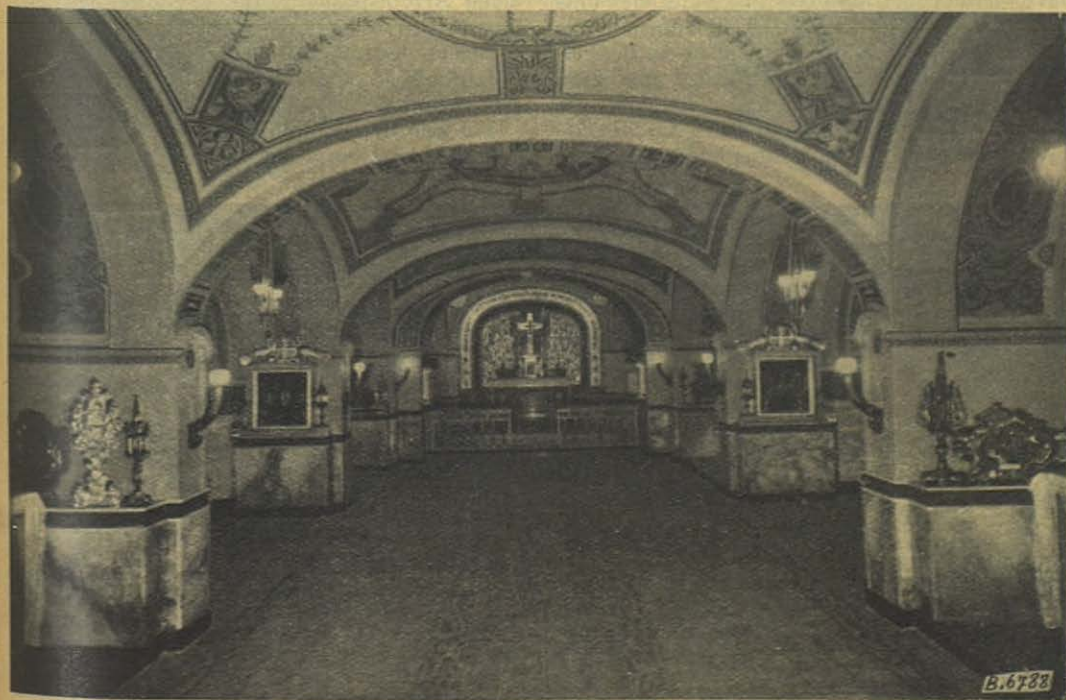
Nave y altar mayor de la Capilla
