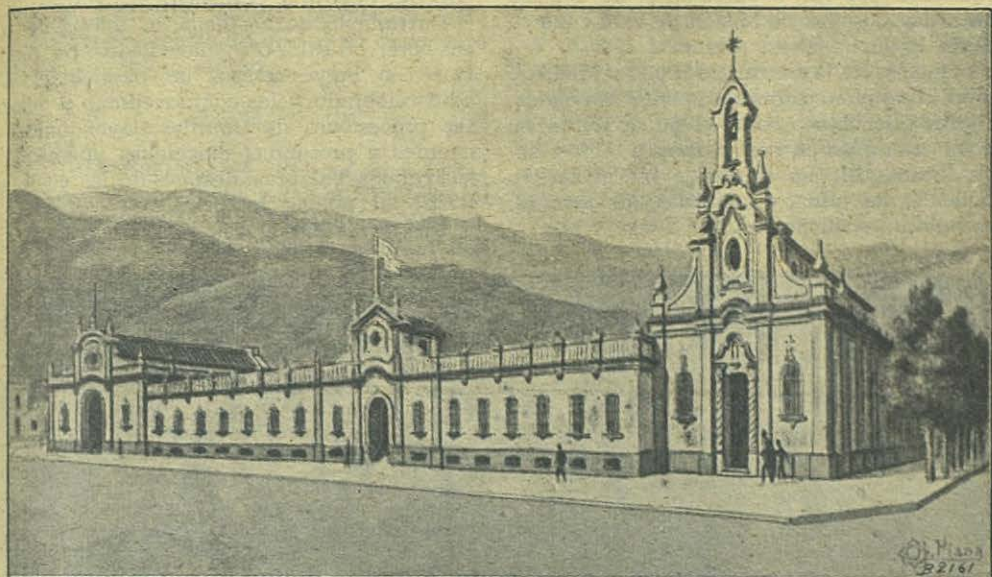
San Juan (Argentina) — Proyecto del Colegio Salesiano en construcción.
