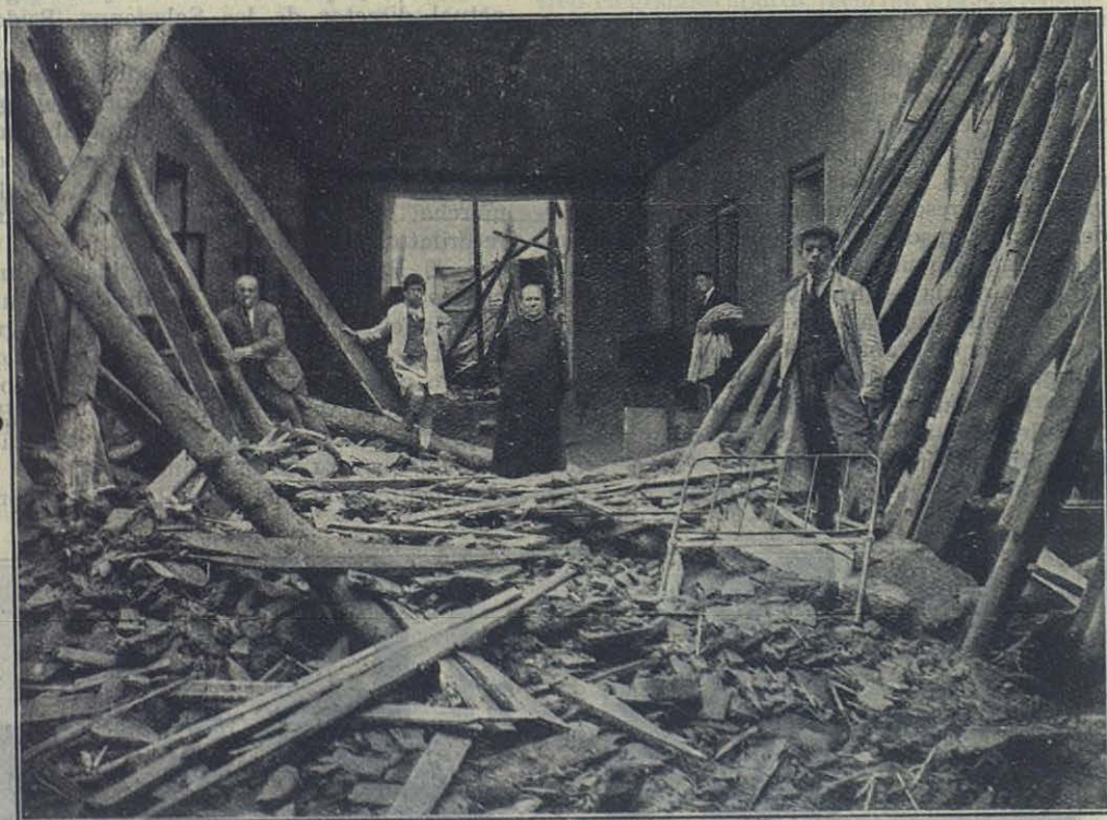
Talca (Chile) — Estado en que quedó el dormitorio del Colegio Salesiano después del terremoto.
