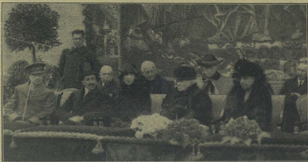
Madrid — Colocación de la primera piedra de la Iglesia y Escuela de los Cuatro Caminos. La Presidencia.
