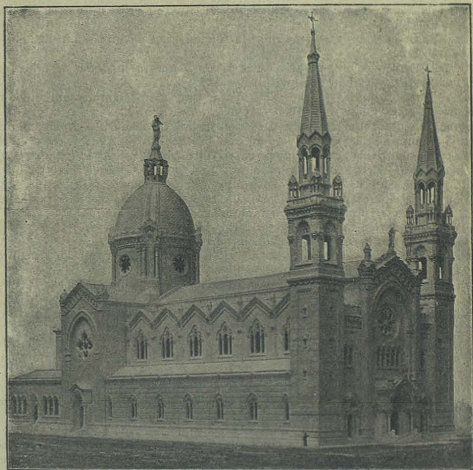
Santuário de Maria Auxiliadora en construcción, en San Pablo (Brasil).
