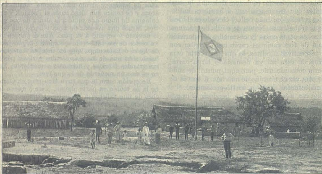
Colonia del Sgdo. Corazón - Edificios centrales, Capilla provisional y Dirección.
