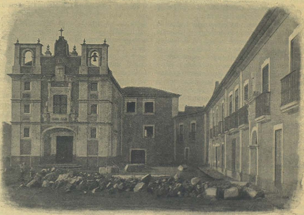
Asilo de huérfanos de los Remedios — Angra do Heroísmo — Azores.
