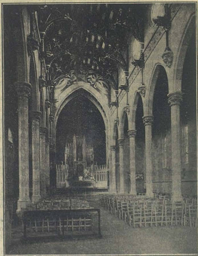
Interior de la nueva Iglesia de María Auxiliadora de Sarriá.
