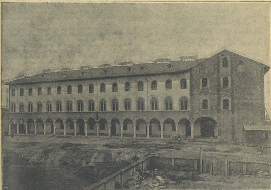
Brazo terminado del Instituto de S. Ambrosio en Milán
